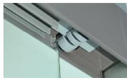
2 Сенсоры детектора положения подъемного экрана
