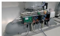
3 Камера отработанного воздуха с выключателем, системой измерения и контролем за измерениями
